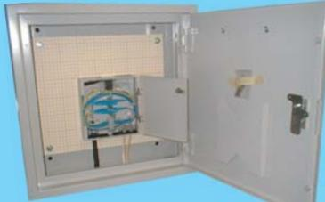
盤内には、幹線を各世帯4芯光ファイバーに振り分ける為の光接続ボックスを設置。(商業ビルの場合、各光コンセントに振り分ける為の光接続ボックス)
